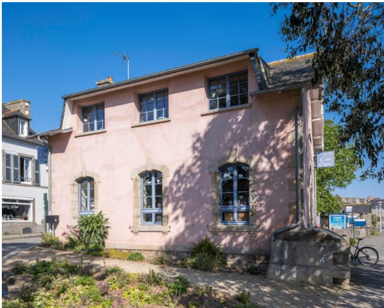
Ancien abri du marin : élévation modifiée lors du changement d'usage
