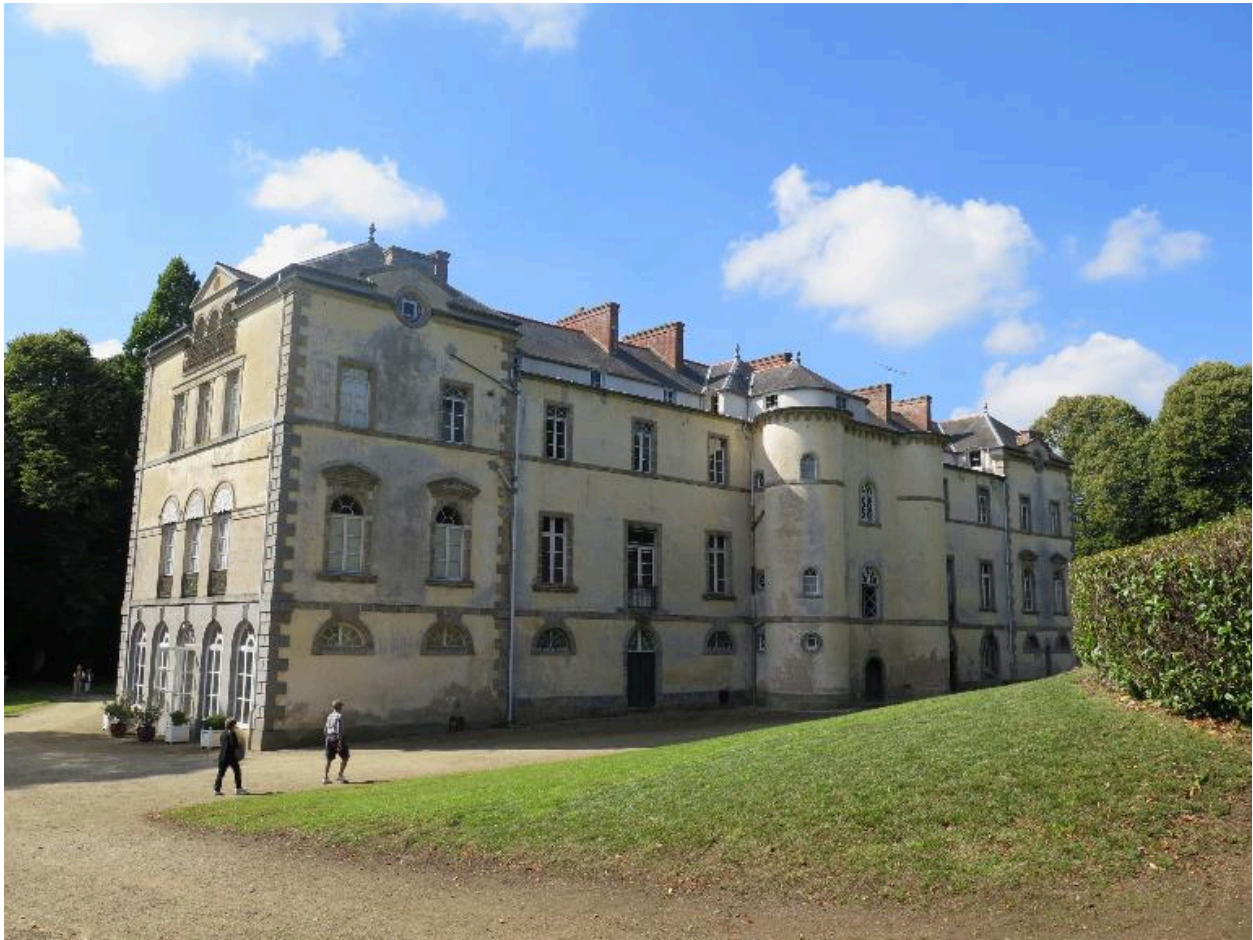
Façade nord, château de Largentaye
