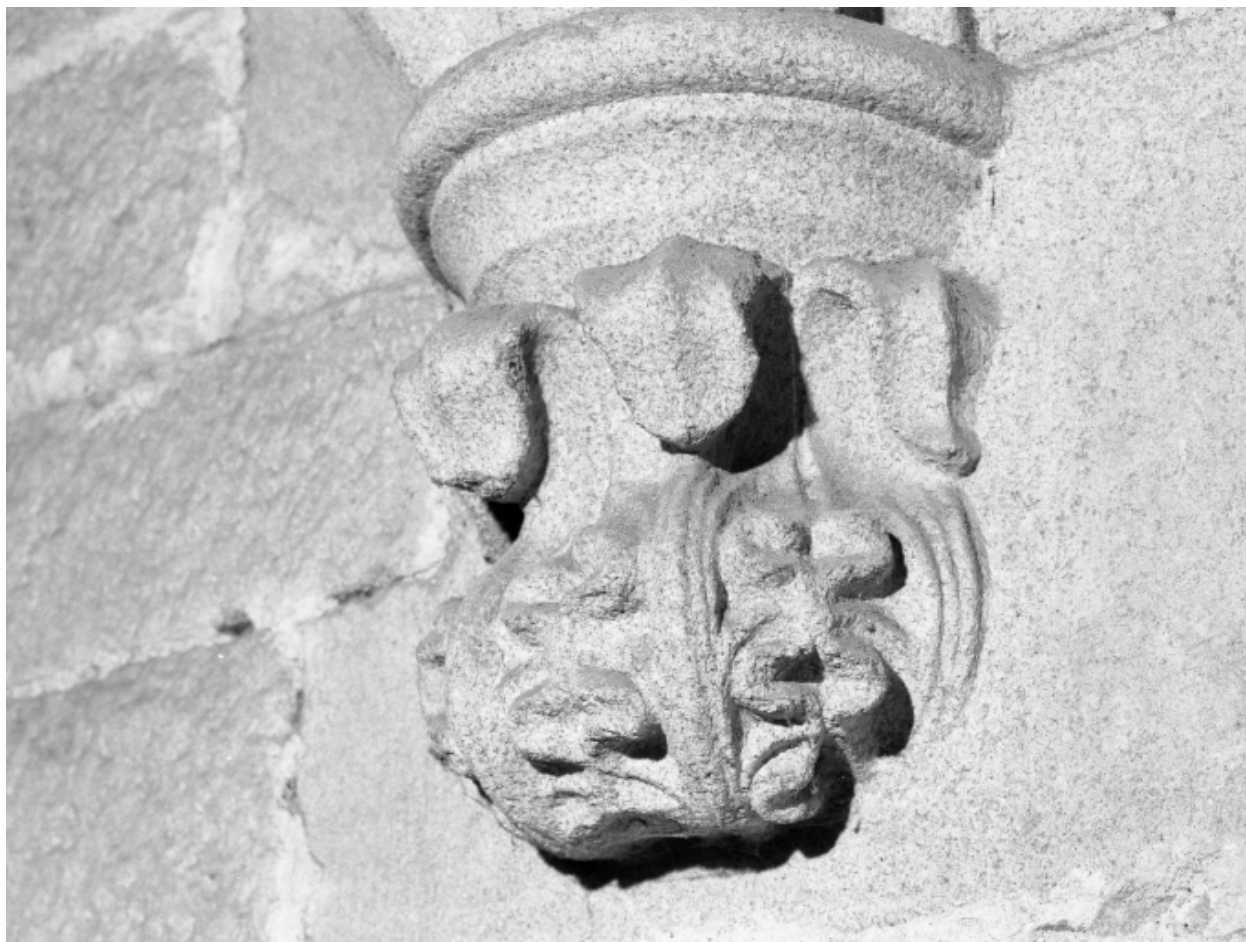
Escalier, 1er repos du rez-de-chaussée : détail du cul-de-lampe sud est
