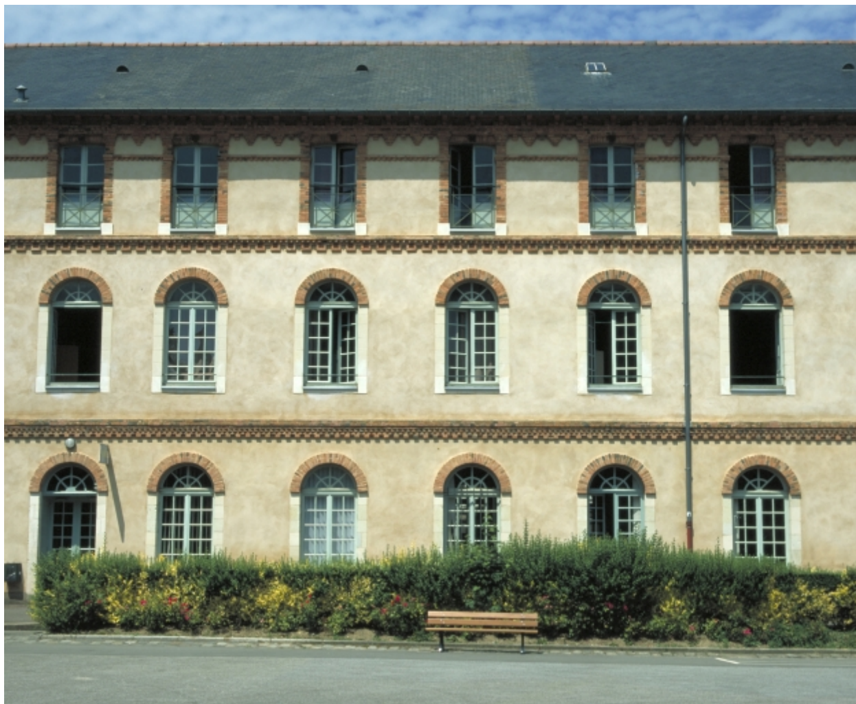
Vue de la façade sud
