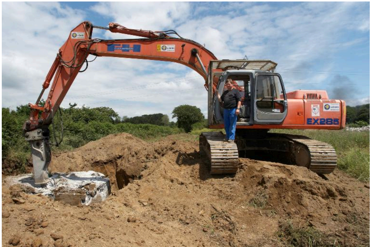
Déconstruction d'un petit bunker - poste d'observation et de tir dit Tobruk-Stand de type 61a. Le conducteur pose pour le photographe
