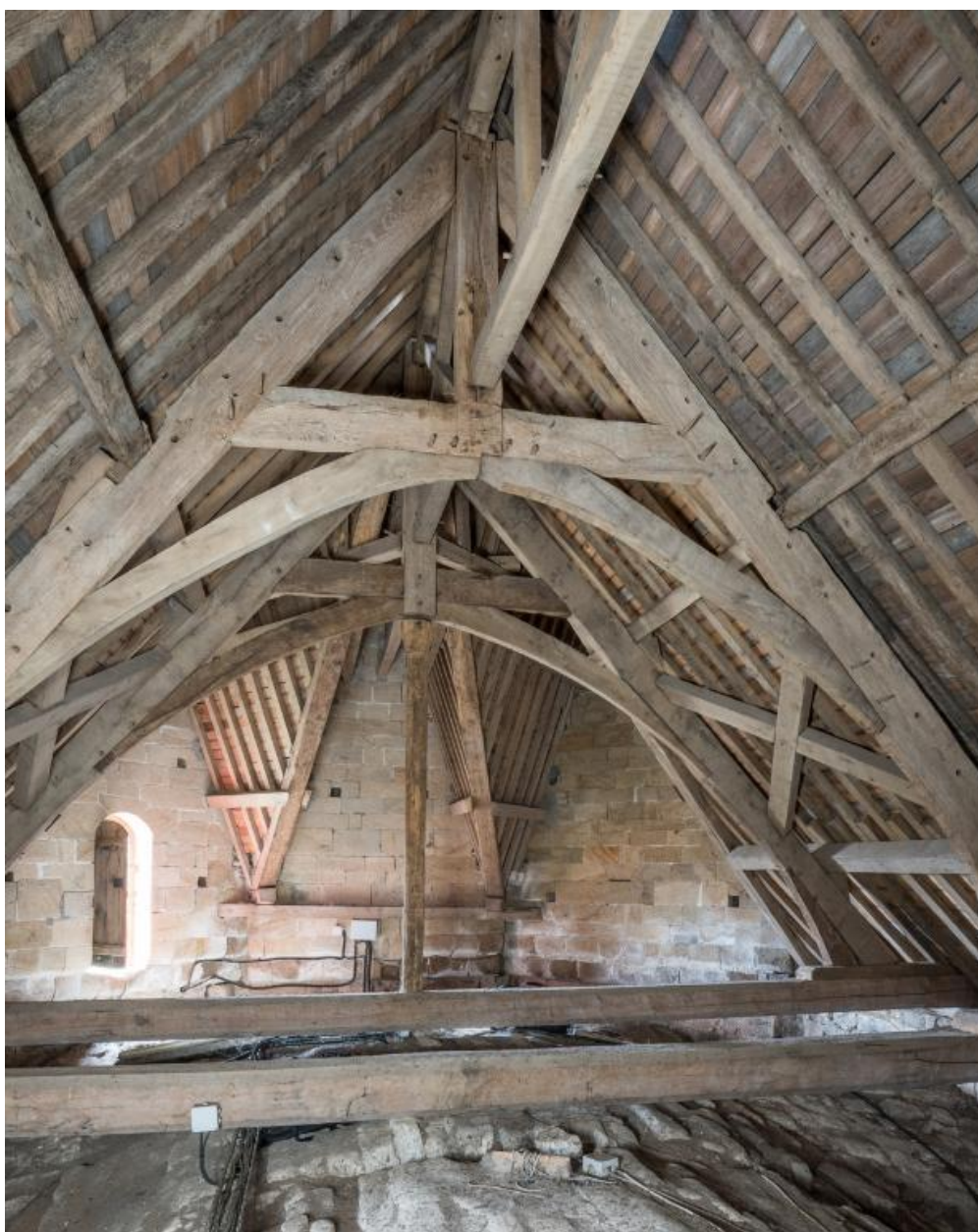
Vue de la charpente du chœur et du revers des pignons de l'abside.
