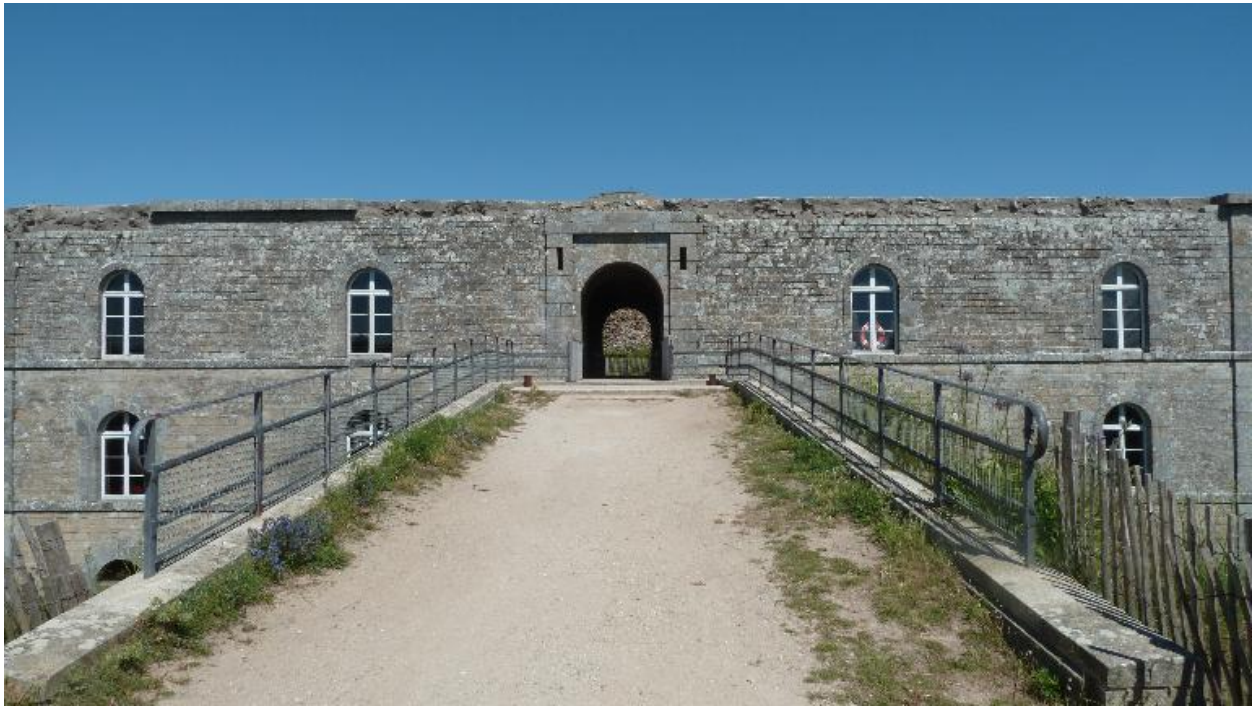
Hœdic, fort central, porte et caserne de gorge.
