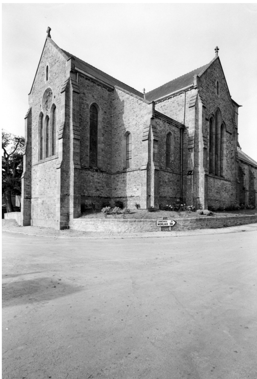
Vue générale de l'angle nord-est
