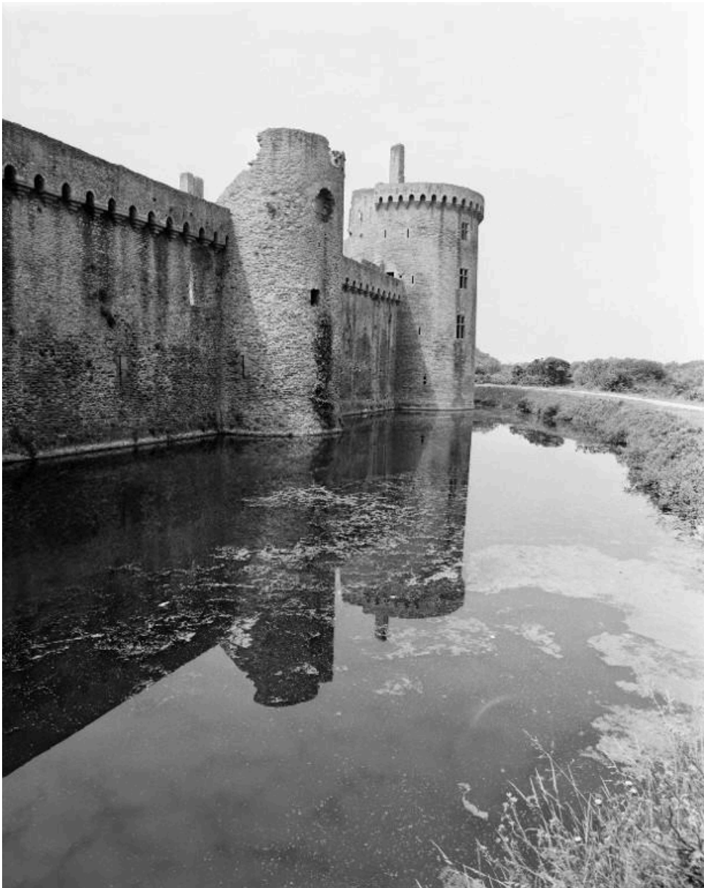
Château fort, courtine nord, partie ouest.
