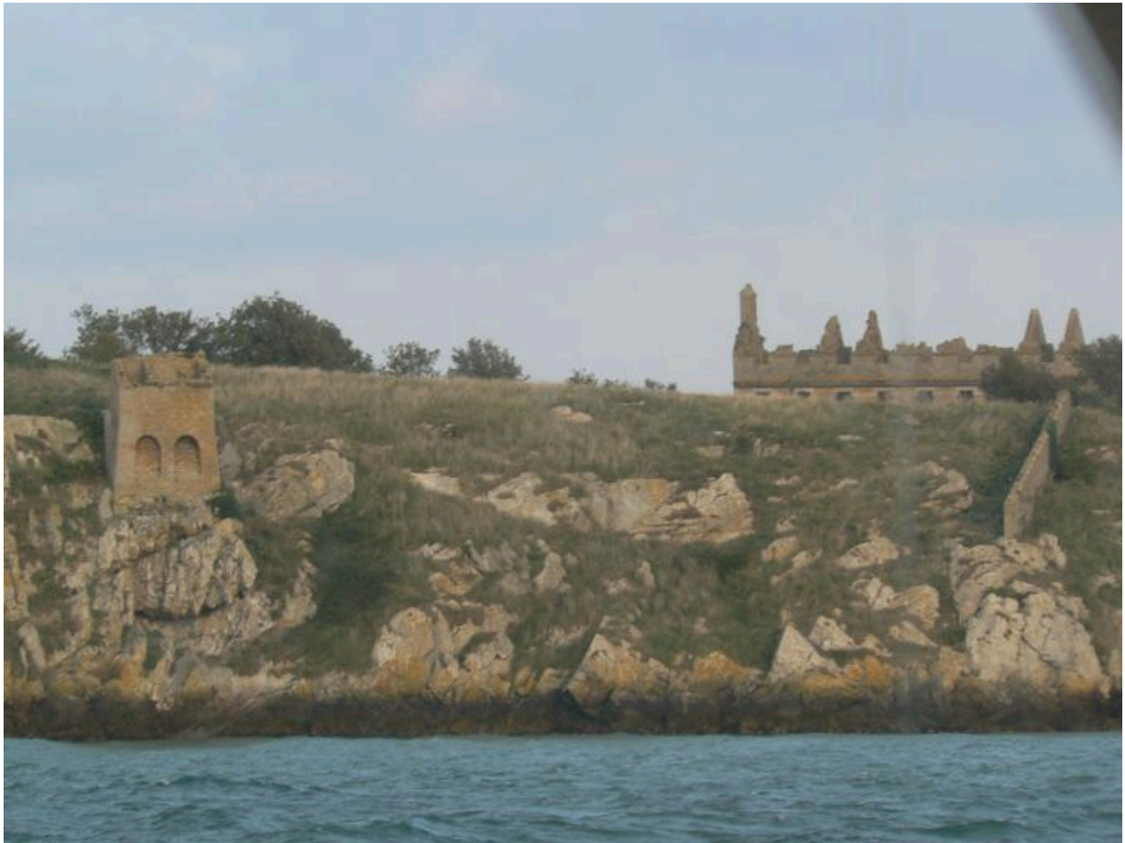
Vue du lazaret (à droite) et des latrines (à gauche)
