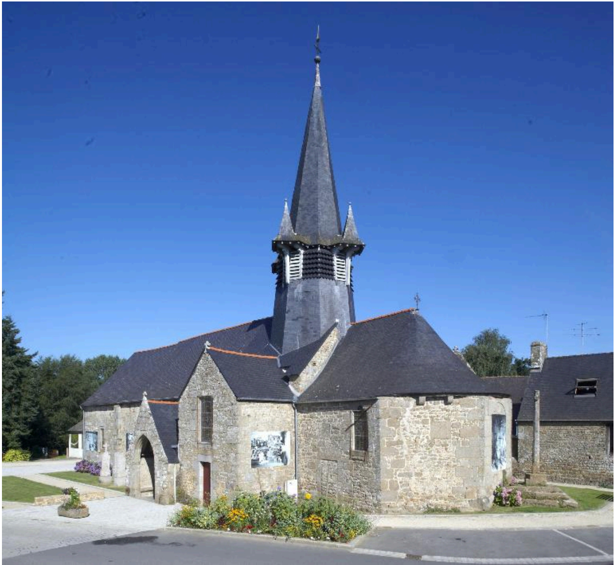
Elévation sud : vue générale
