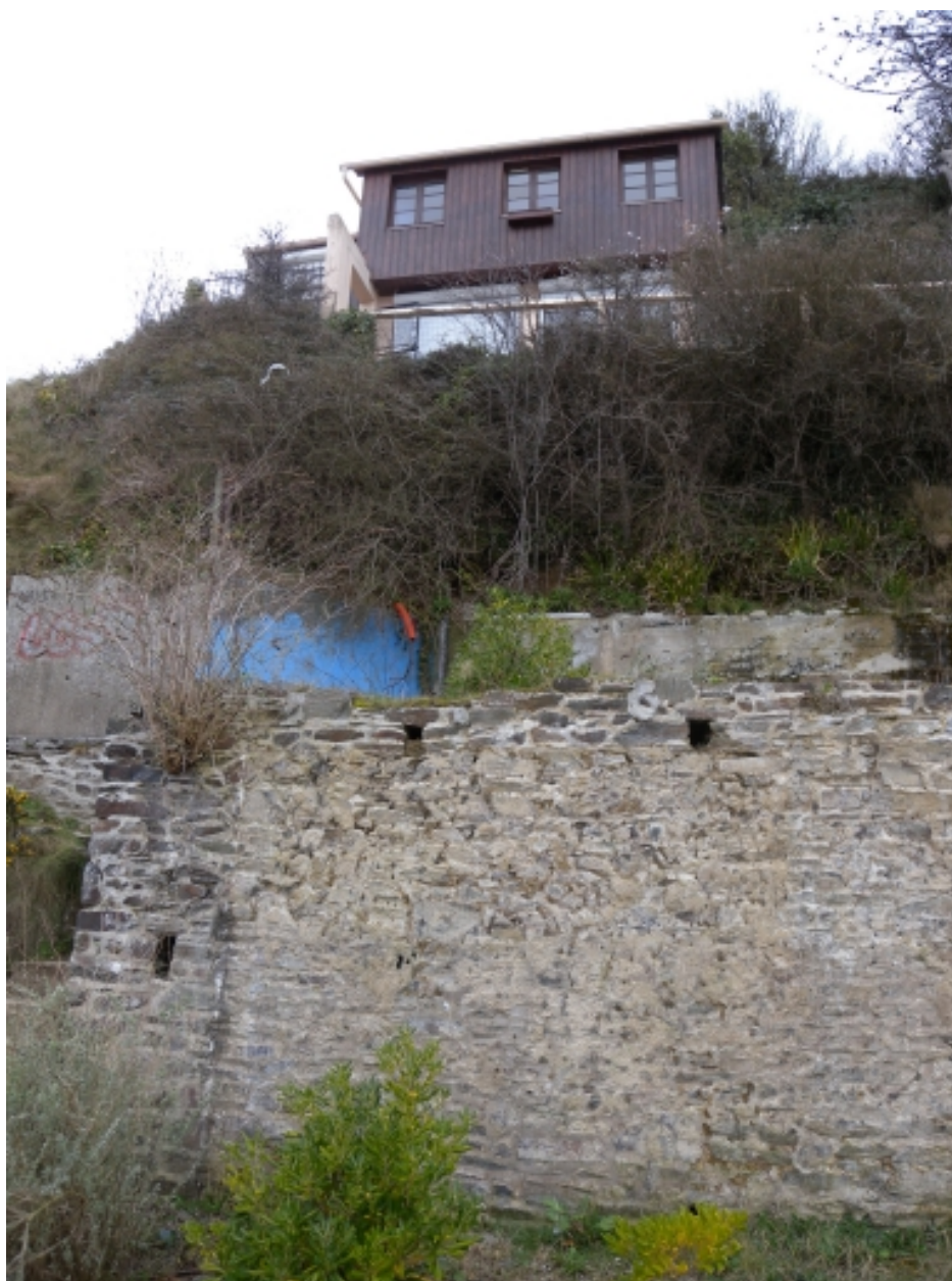
Bâti littoral sur le chemin de la corniche, avec son mur de soutènement
