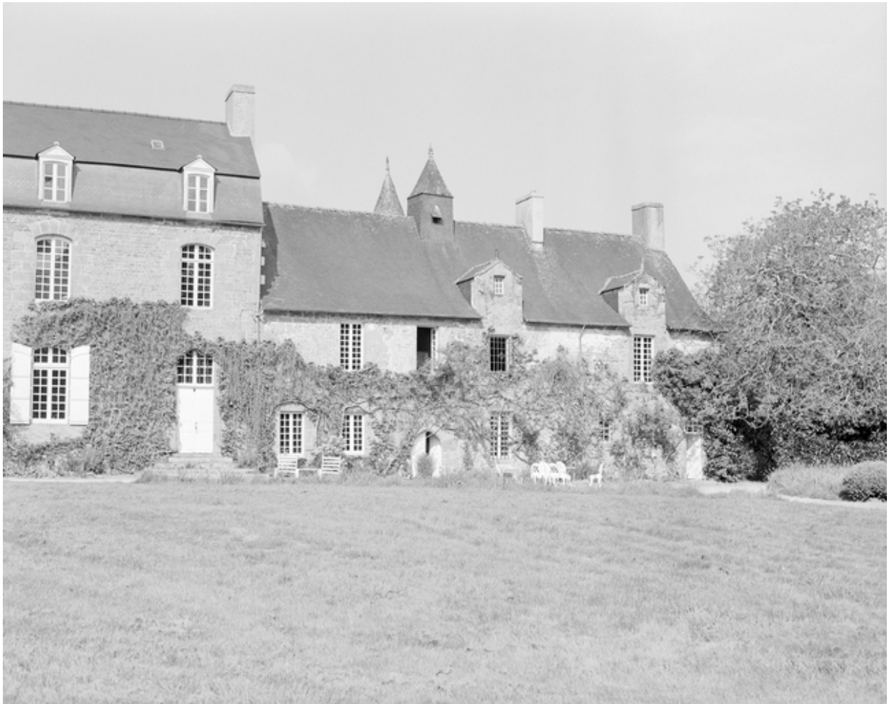
Vue générale de la partie ancienne.
