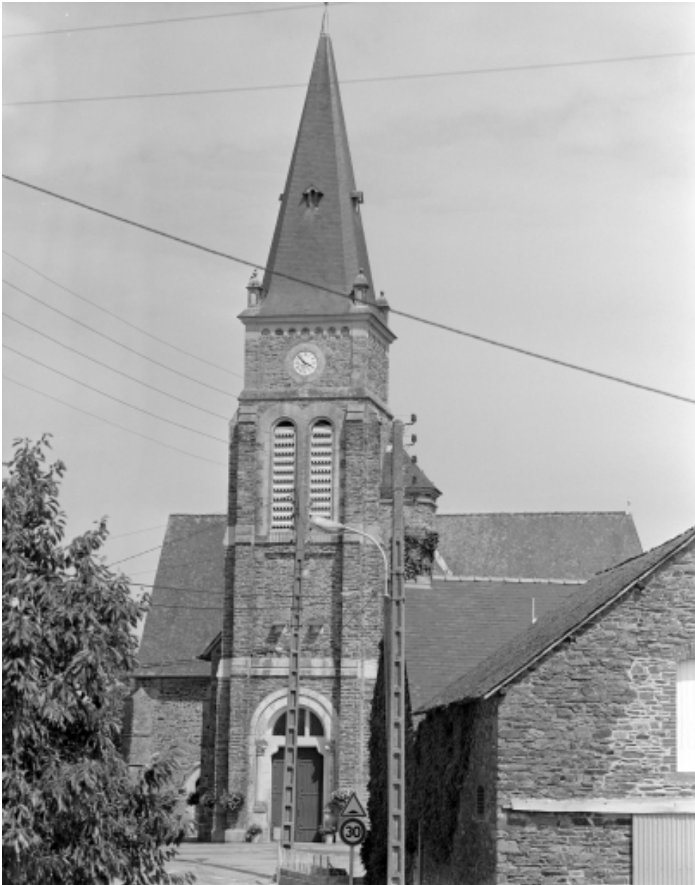
Elévation Ouest : vue générale
