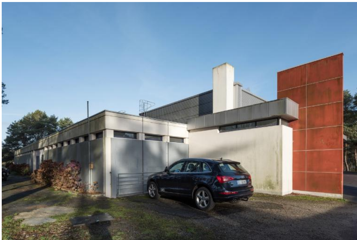
Vue générale prise du sud
