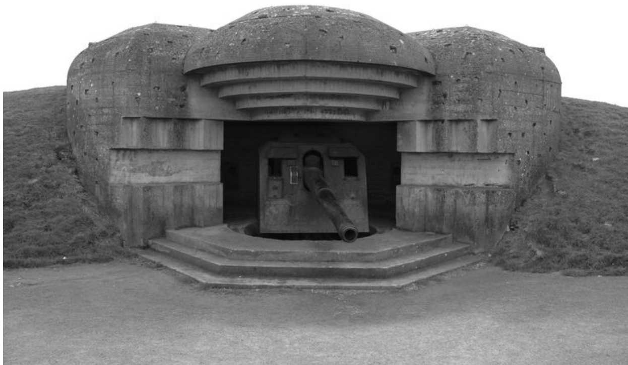
Vue générale de l'une des quatre casemates de la batterie de Longues-sur-Mer (casemate n° 4 depuis l'est)
