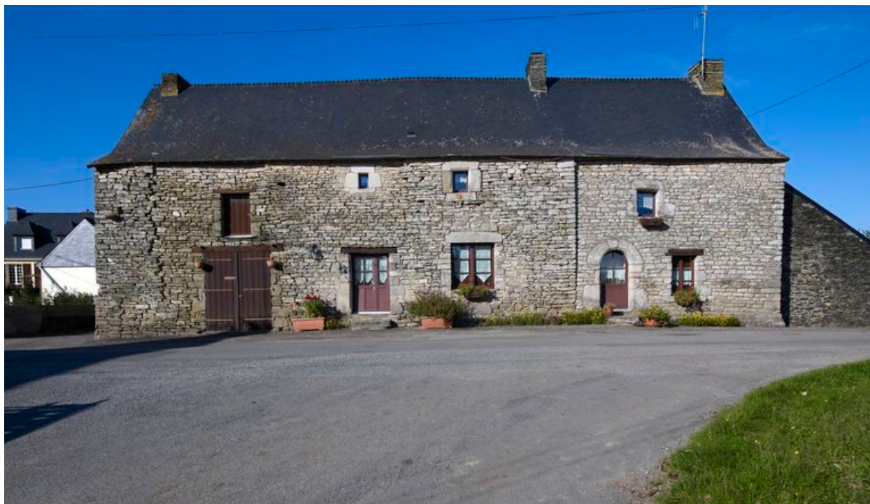
La Ville Fichet : ferme 1 (à gauche) et maison de prêtre datée 1569 (à droite) (état en 2010)
