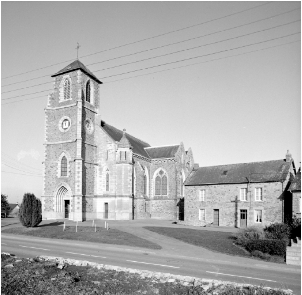
Elévation Sud-Ouest : vue générale
