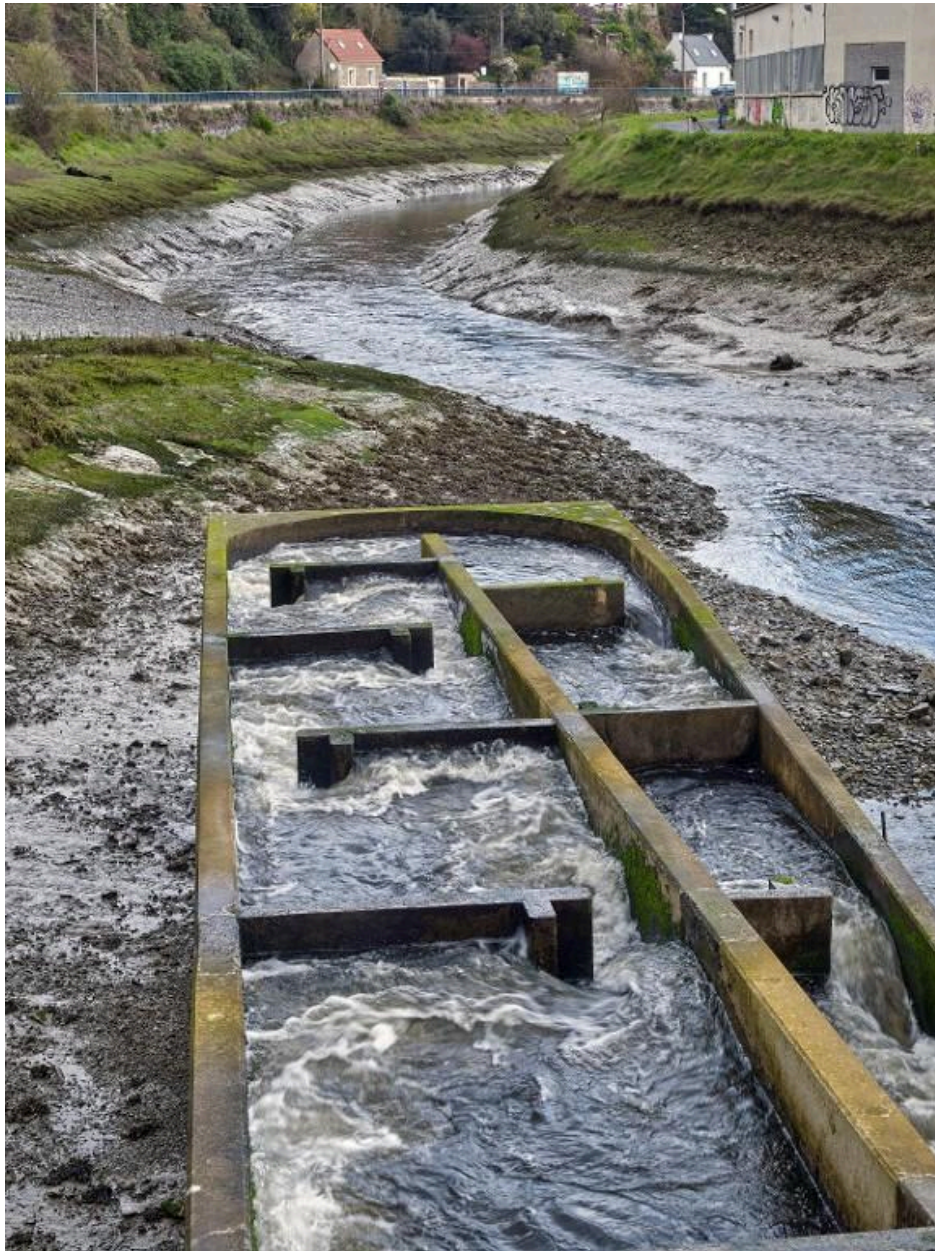
La passe à poissons du bassin à flot située à proximité de l'île sèche
