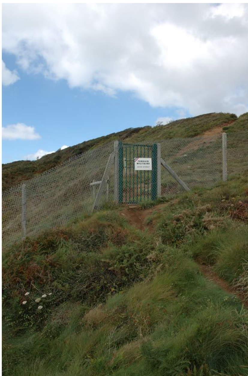
Vue de la clôture délimitant l'emprise militaire : signalétique en place (état en 2007)
