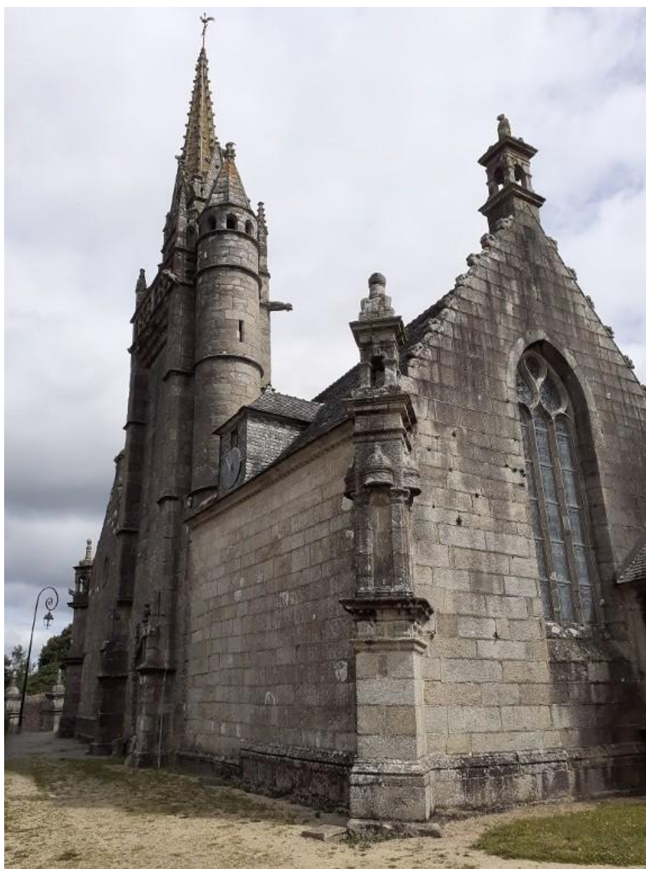
Clocher, vue depuis le sud
