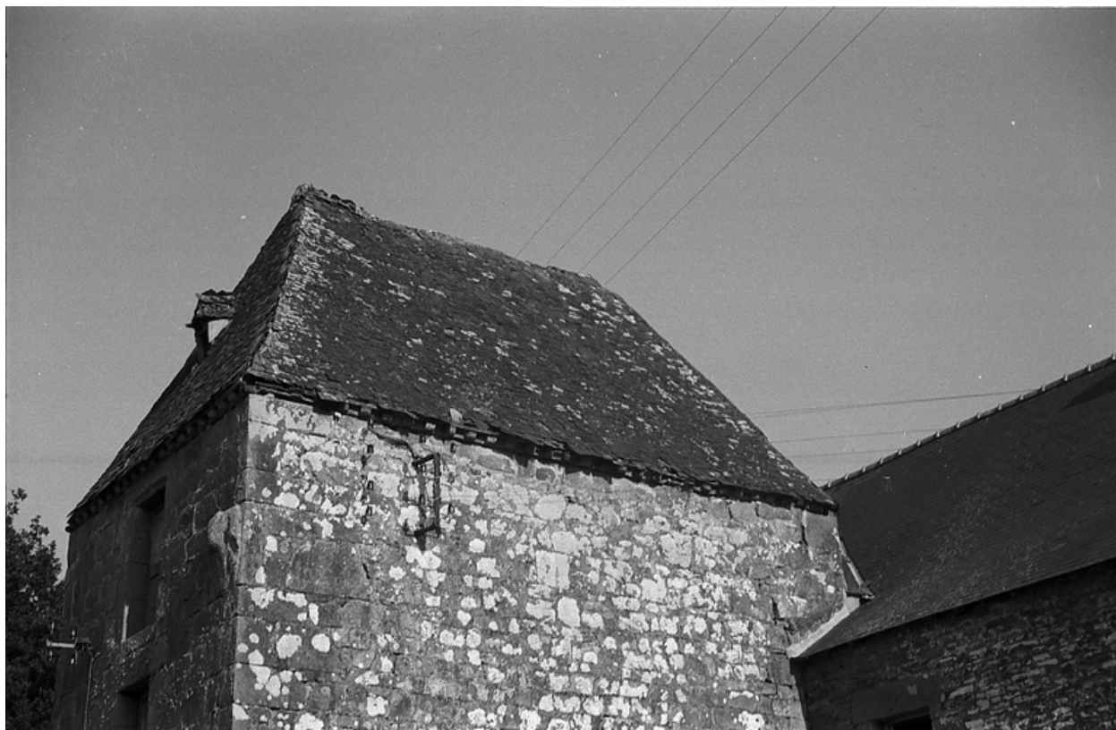
Façade nord, tourelle d'escalier : détail du dernier niveau et de la toiture
