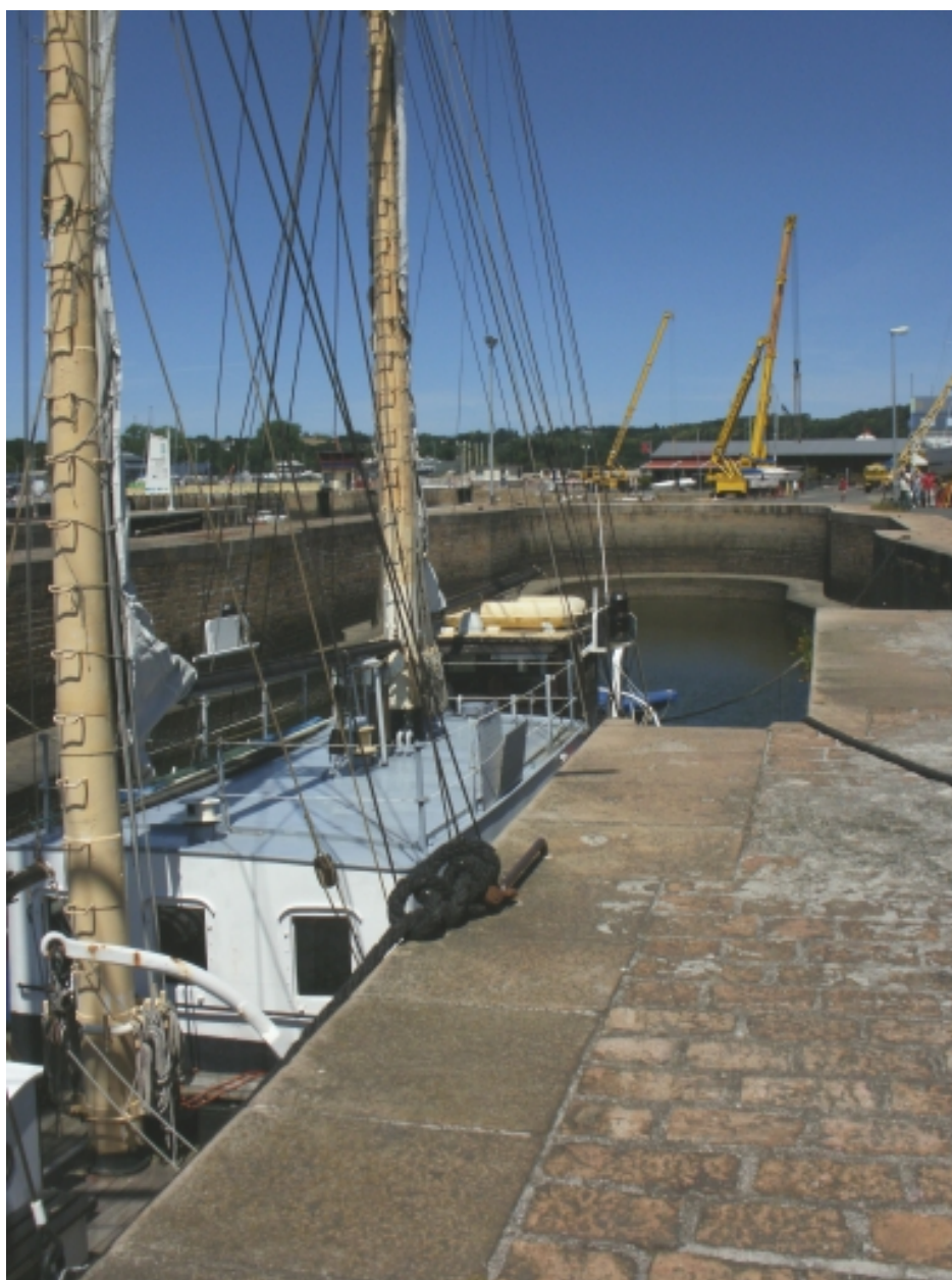
Vue de la forme de radoub et des quais
