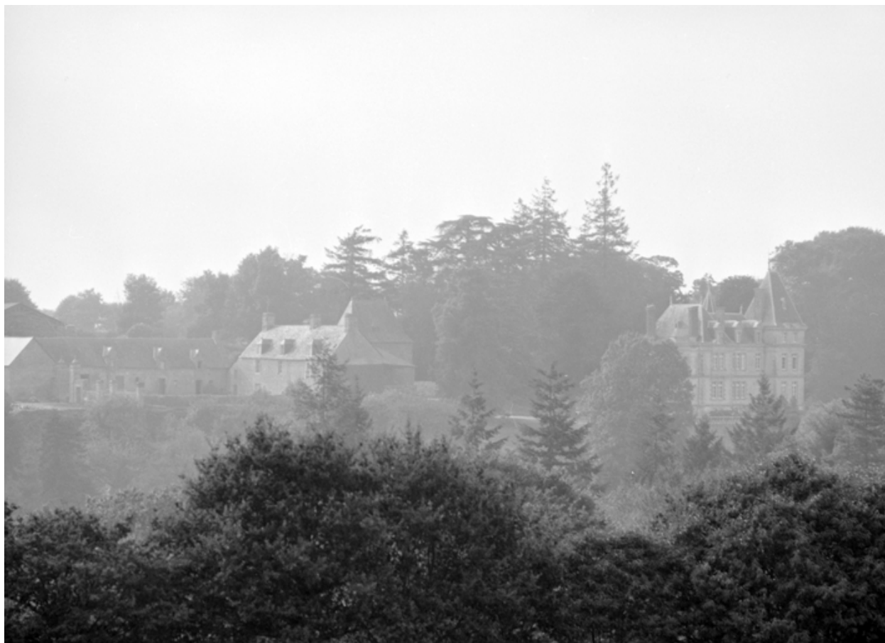
Vue de situation sud-est.
