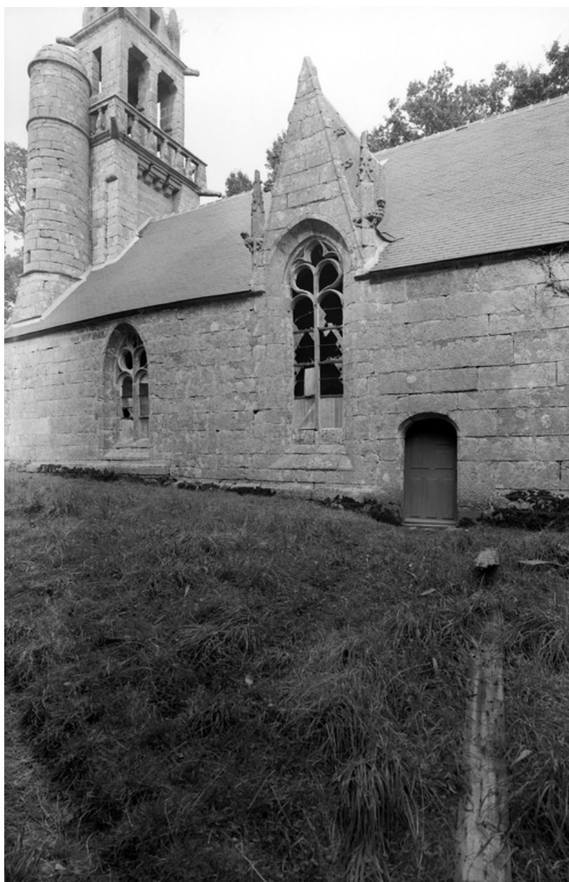
Vue de la face sud de la nef
