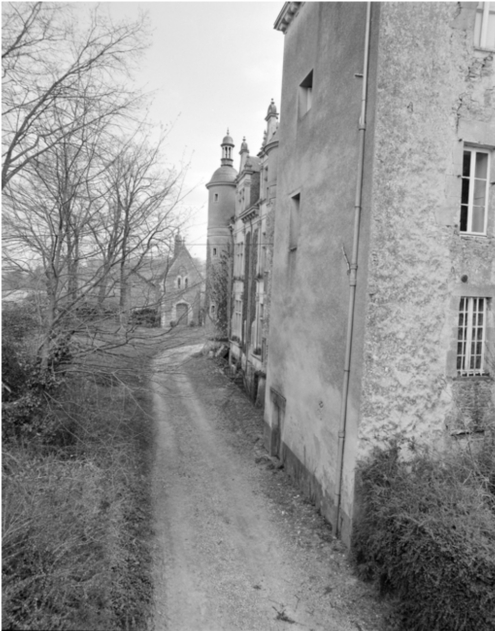
Vue générale de 3/4 nord-est.
