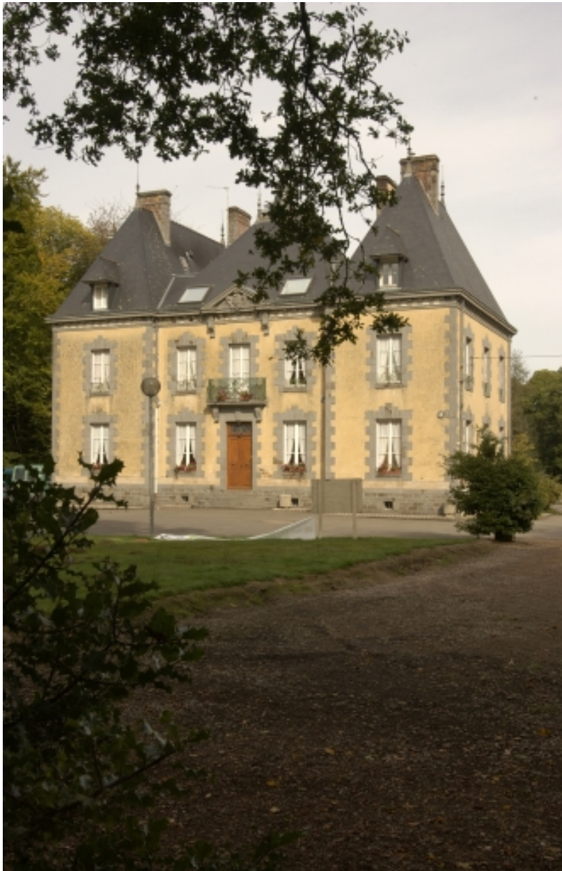
Vue d'ensemble sud-est
