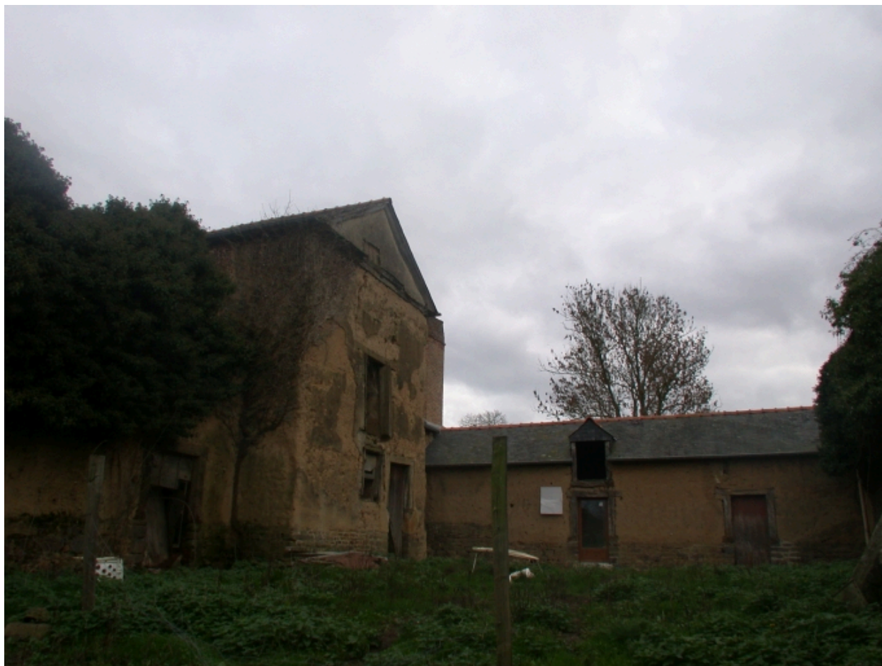
Les communs, vue générale arrière
