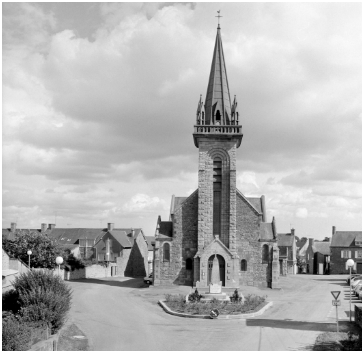
Elévation Ouest : vue générale
