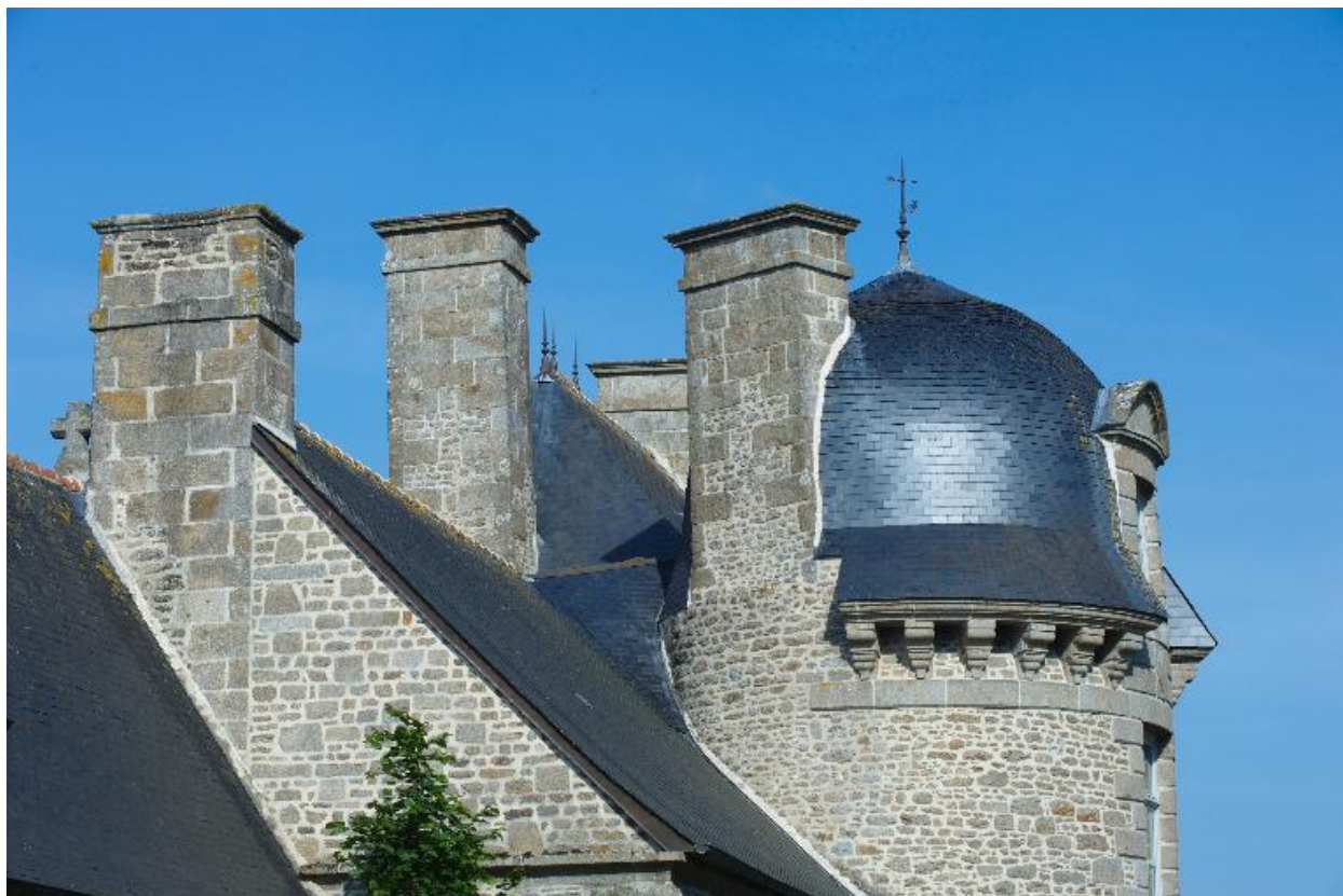
Souches de cheminées
