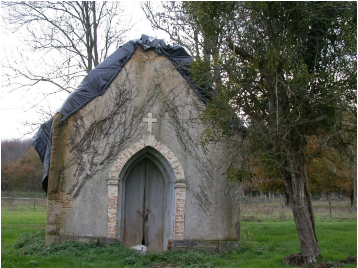
Vue d'ensemble de la chapelle
