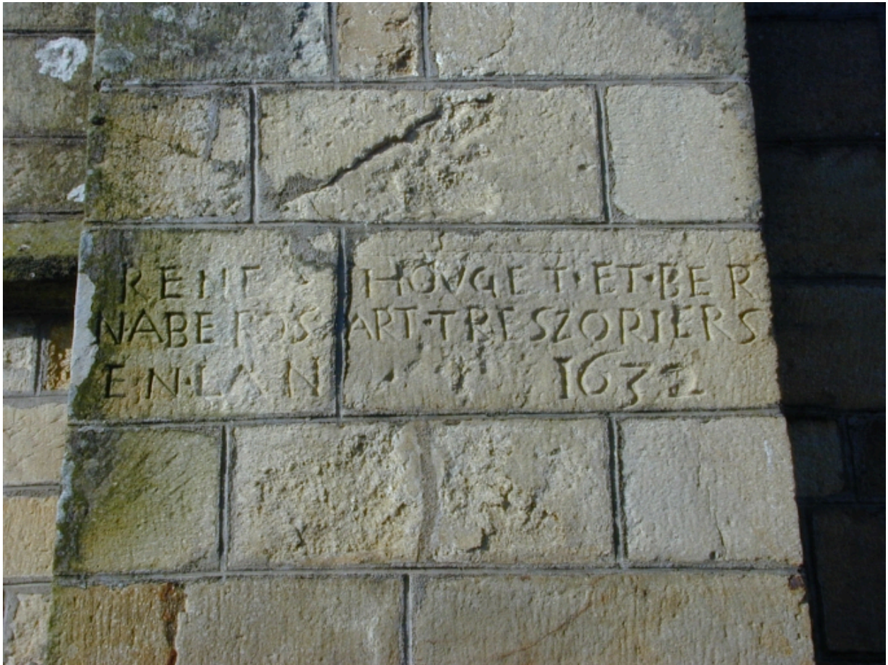
Façade sud, détail, contrefort avec inscription et date portée 1632
