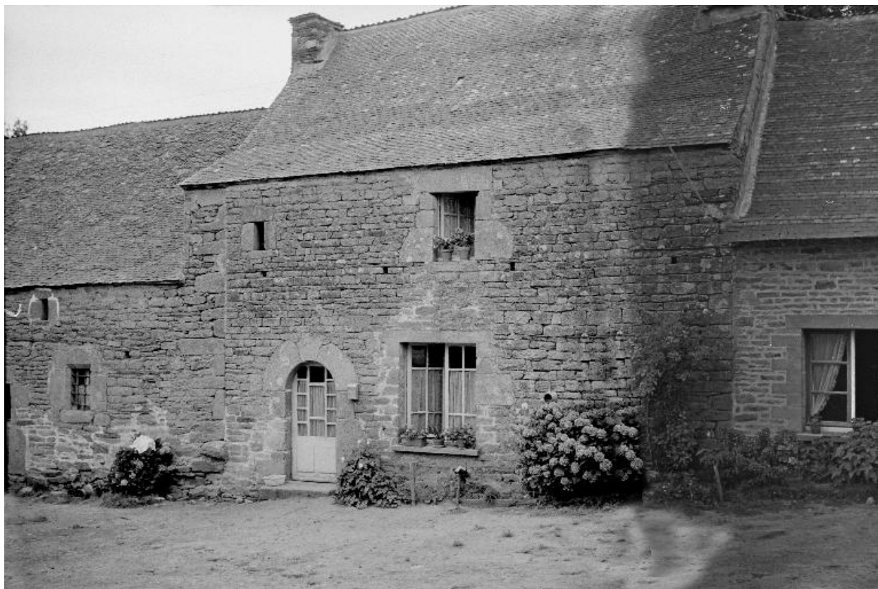
Ferme 41 (état en 1969)
