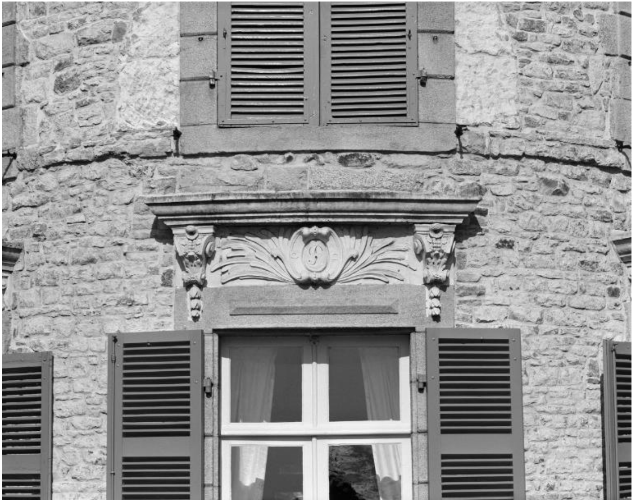
Elévation est, porte centrale, linteau.
