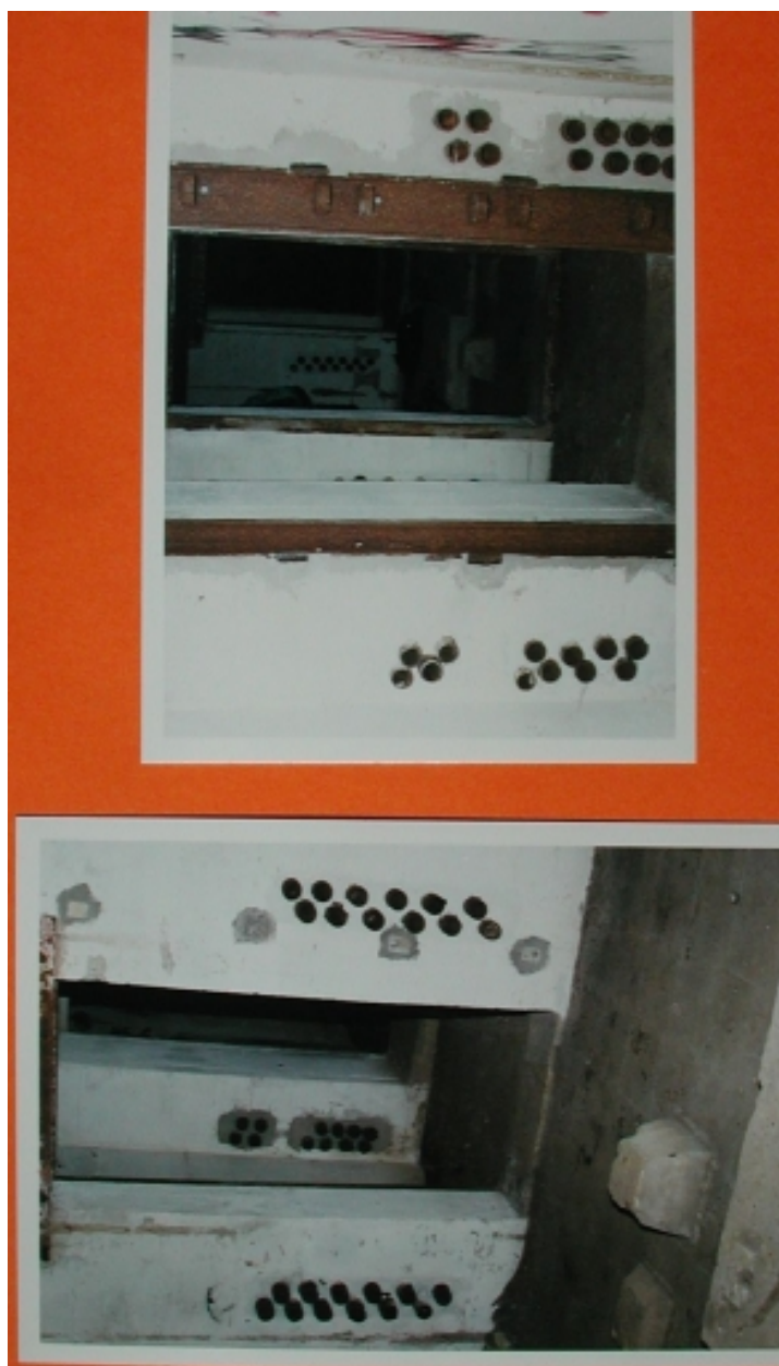
Descente des piliers dans l'abri du radar Mammot
