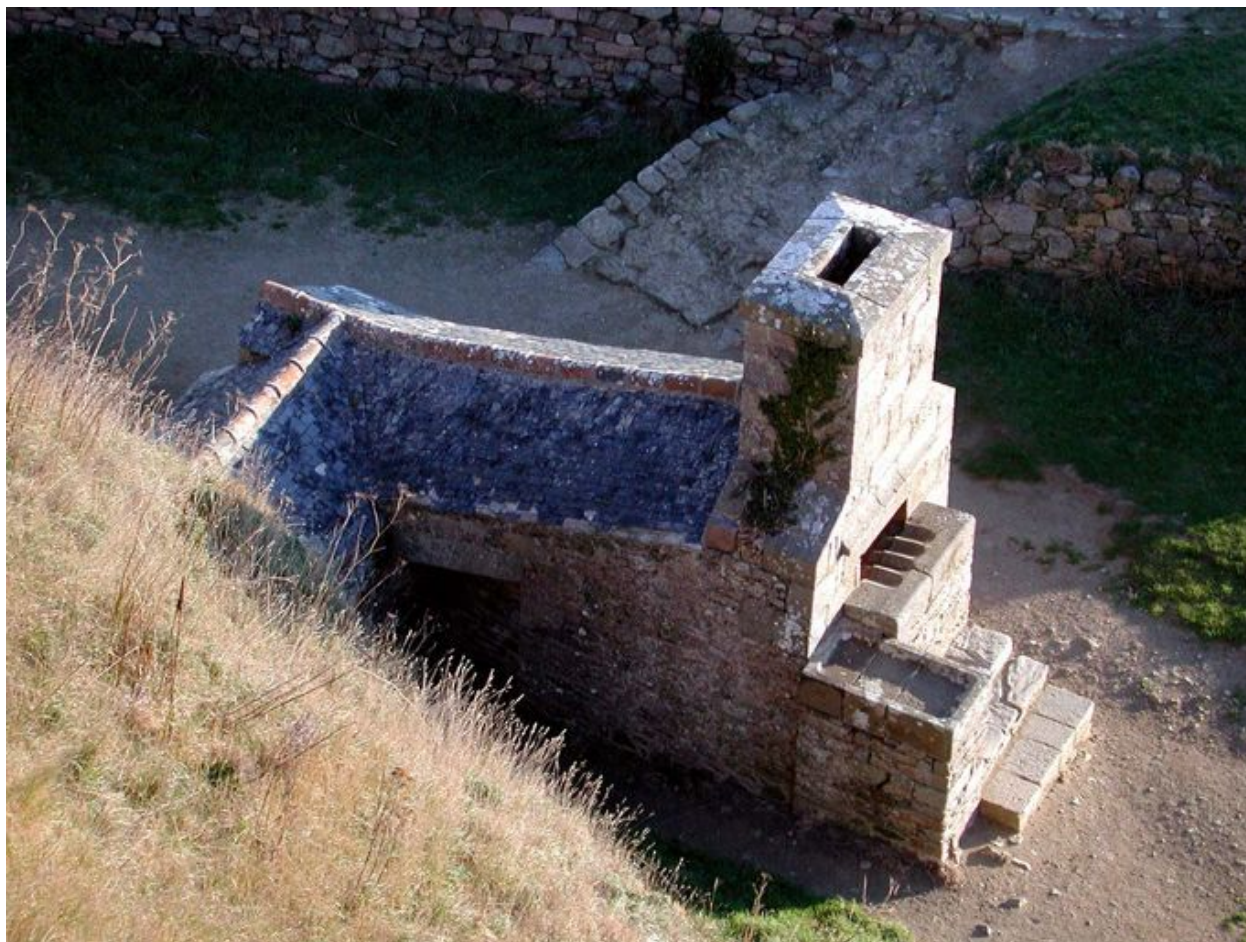
Vue du four à boulets du Fort La Latte à Plévenon (état en 2002)
