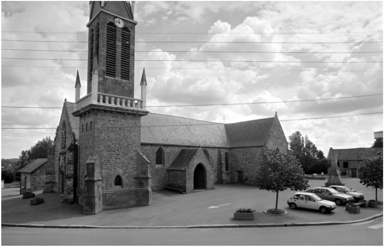
Elévation Sud : vue générale
