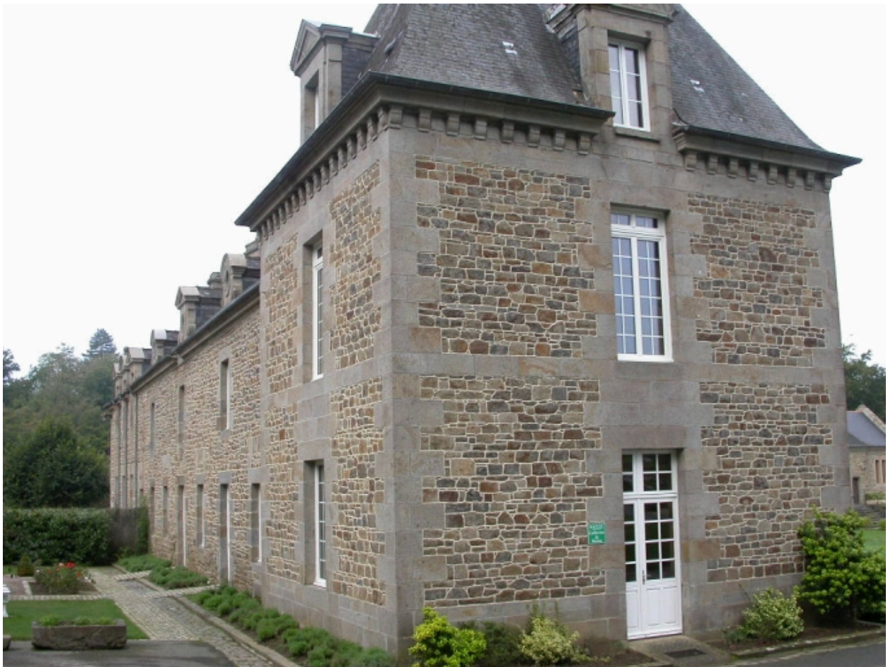
Aile sud, vue sud-est
