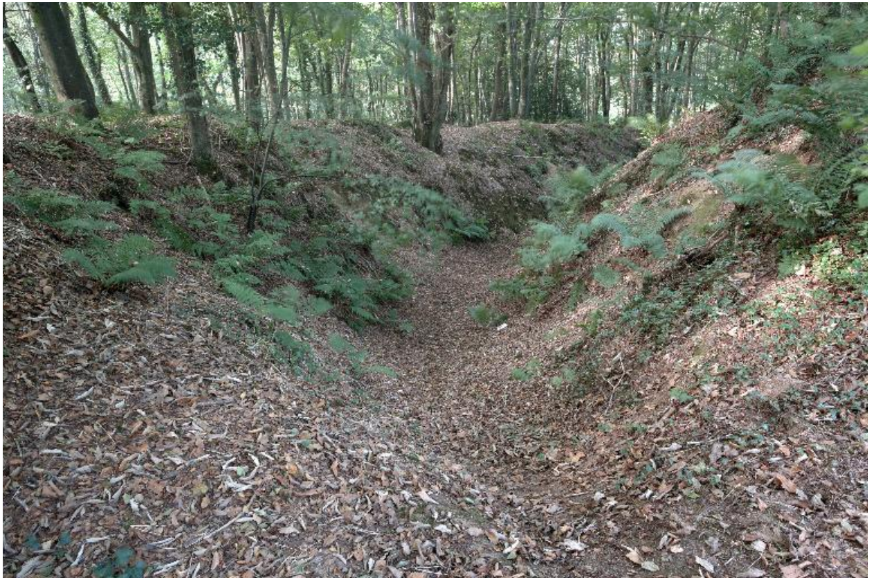
Vue du fossé et du talus de la basse-cour, état en 2016
