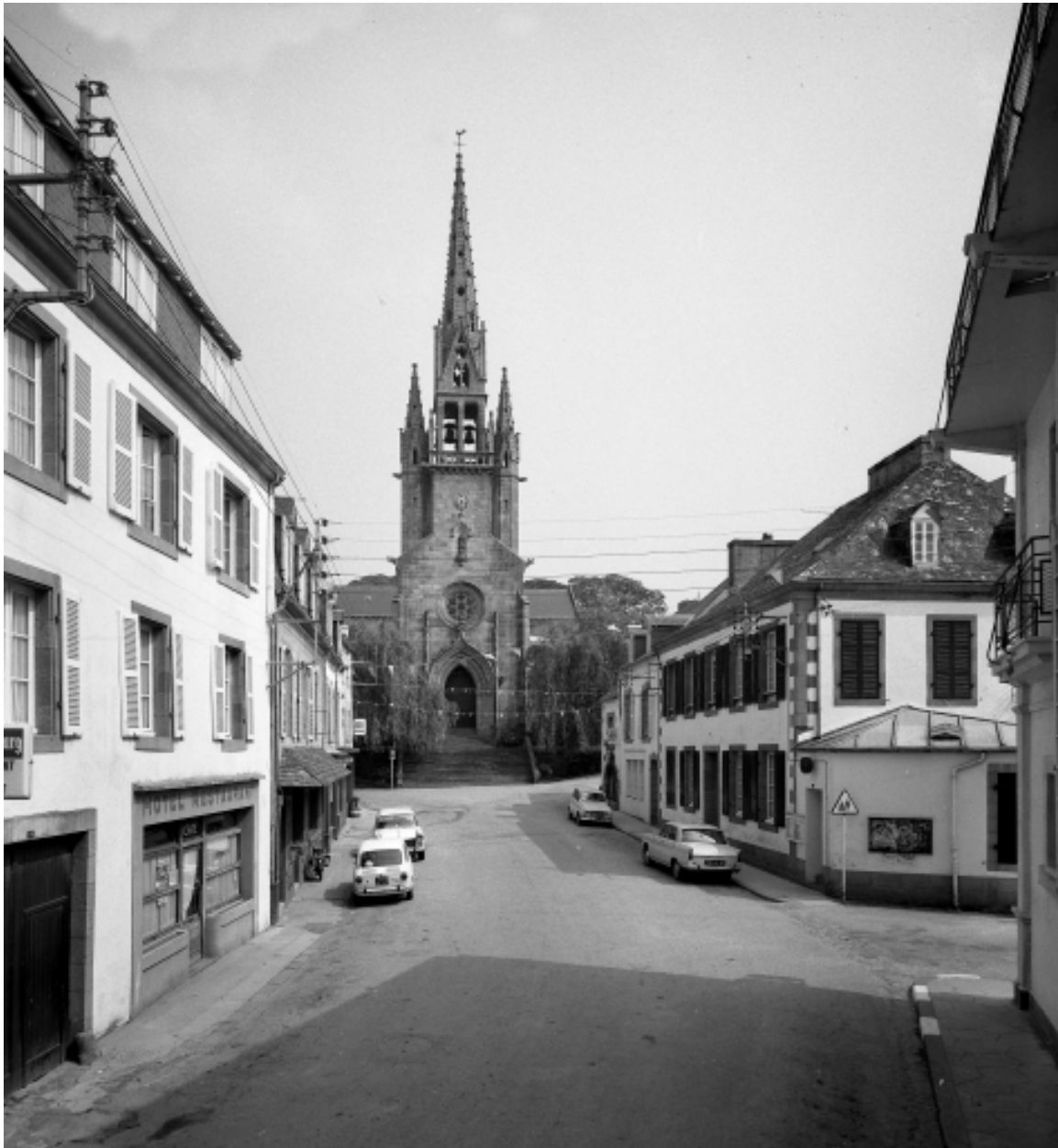
Châteaulin, église paroissiale Saint-Idunet : vue de situation prise du nord-ouest, état en 1972
