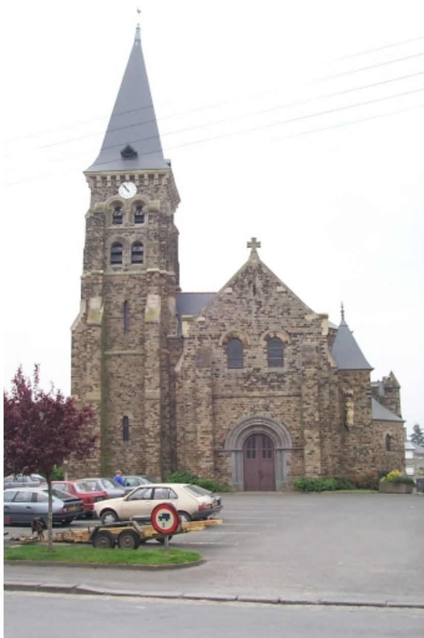
Élévation nord : vue générale
