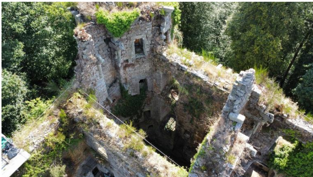
Vue aérienne oblique depuis l'ouest : corps de bâtiment sud-est du grand corps de logis et tour orientale
