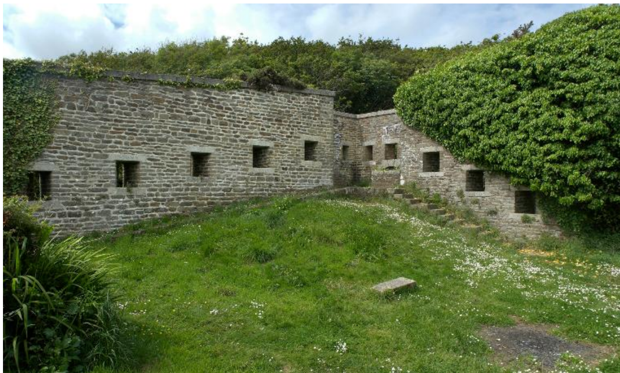
Plouzané : vue du fort du Dellec, mur d'enceinte ouest percé de créneaux de fusillade. Bastionnet à mâchicoulis ou créneaux de pied
