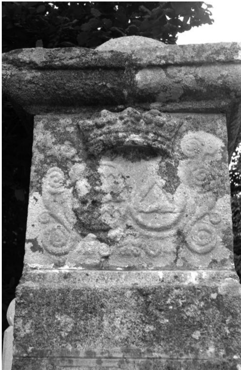
Vue de l'un des piliers de l'entrée : détail des armoiries (état en 1983)
