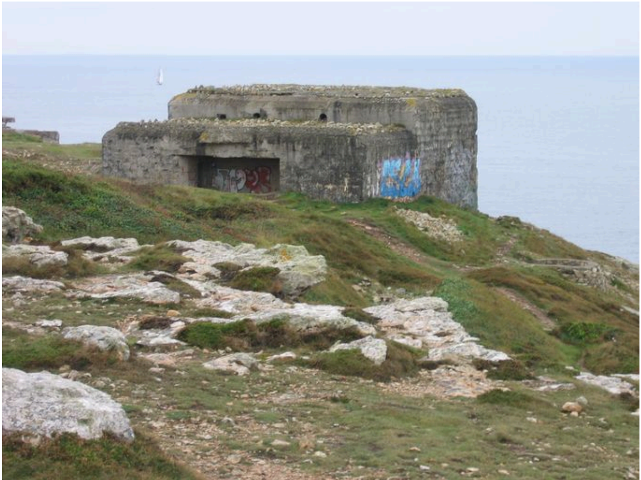
Casemate de la batterie de mortier française
