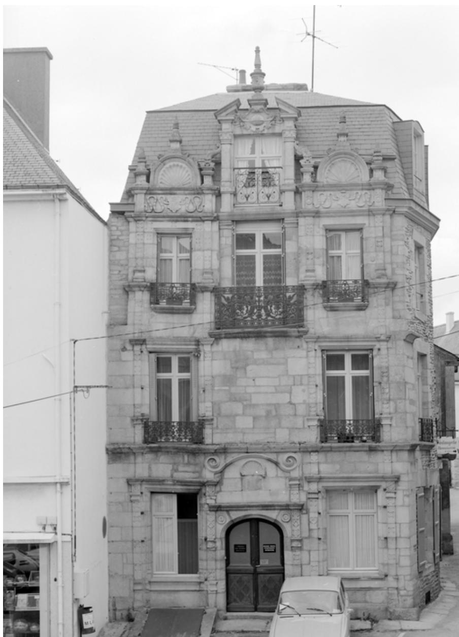
Maison : élévation sud (état en 1985)
