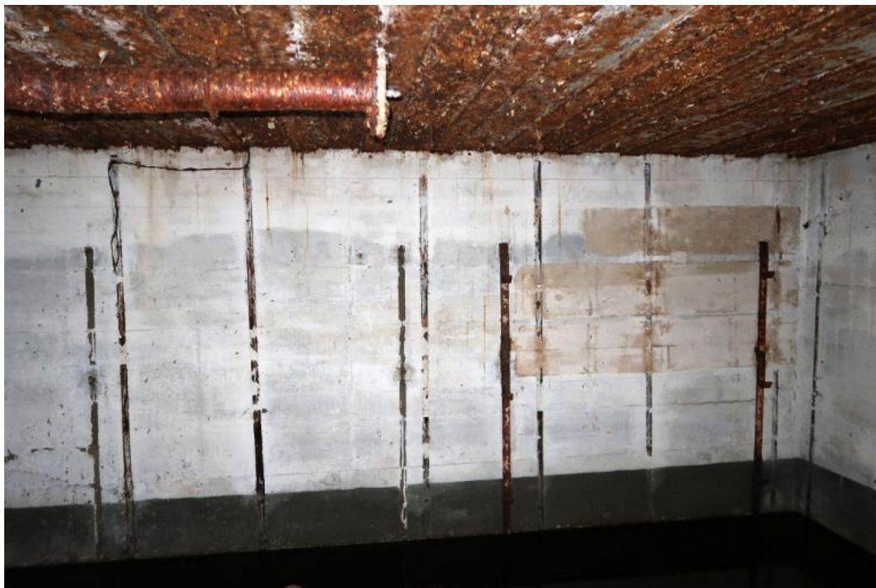
Vue intérieure : salle de garde nord, détail du mur ouest avec les supports muraux pour six couchettes tubulaires
