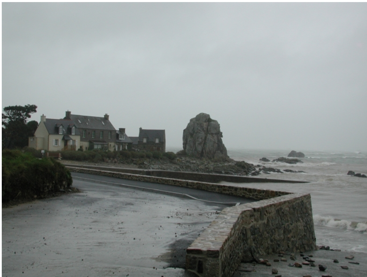
Vue de la digue-mur et de la cale de Pors Hir
