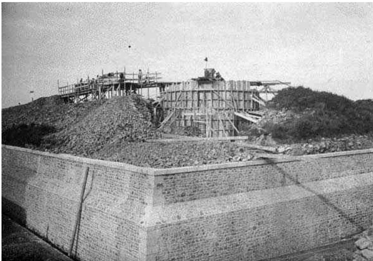
Vue du chantier de construction du réduit, vers 1902-1906 : coffrage du puits de l'une des deux tourelles pour canons de 75 mm. Au-dessus : voie ferrée de type Decauville sur laquelle évoluent deux wagonnets tirés par un cheval
