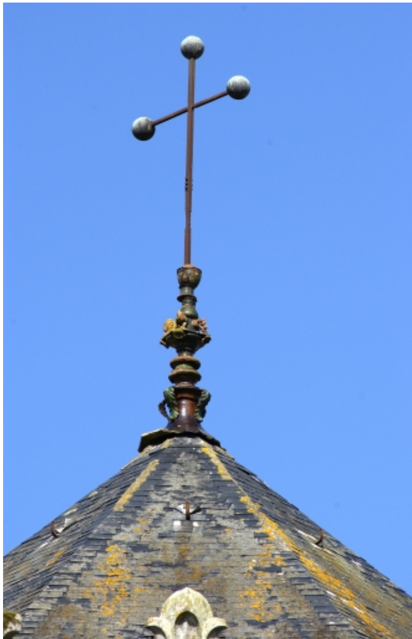
Détail du couronnement de la toiture centrale
